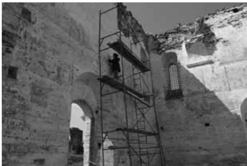
8. Никольский собор Антониева Краснохолмского монастыря. Работы по фиксации стенописи в мае – июне 2010 г. Фотография В.А. Шестакова
